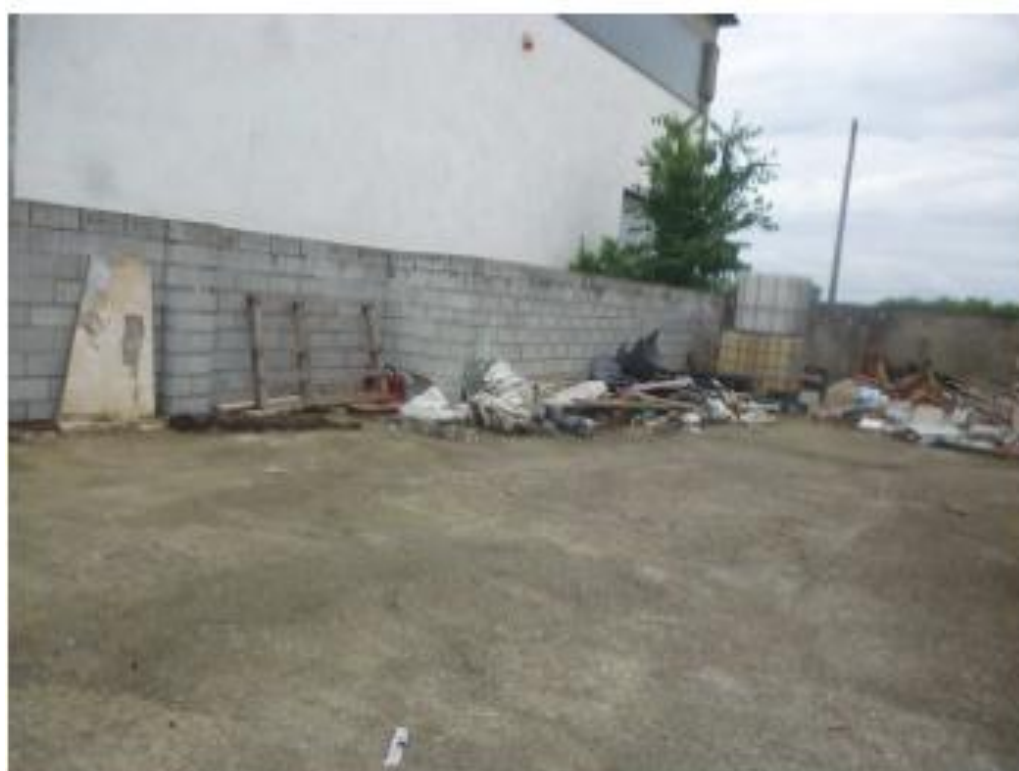
6- Cortile e muro di confine sud-ovest
