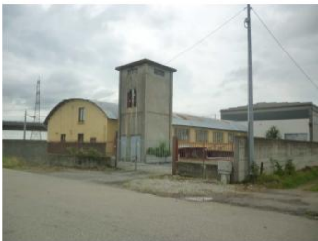
8- Fronte nord est –nord ovest
