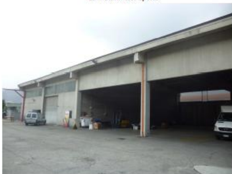
20- Fronte edificio e confine con altra proprietà
